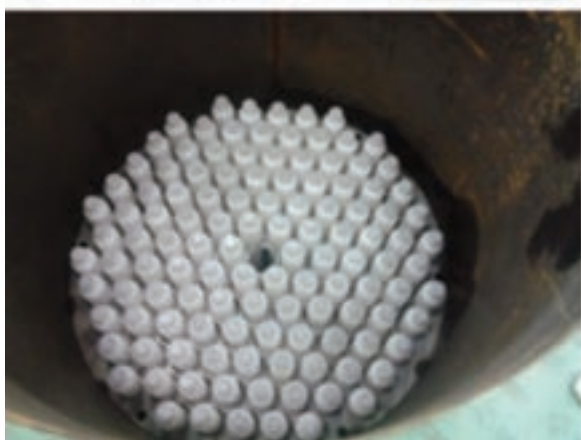
Sistema di accumulo PCM, vista dall'alto del serbatoio
