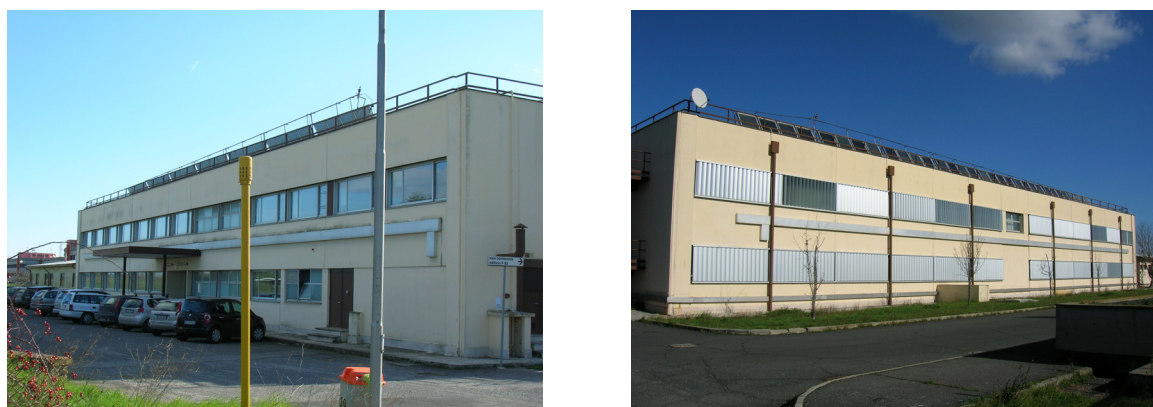
Figura 141. Prospetto nord e sud dell'edificio F51
