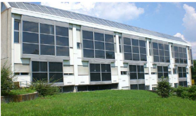
Figura 168. L'edificio "Corpo B" del centro ENEA di Ispra
