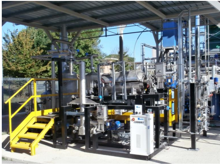
Figura 270. Piattaforma VALCHIRIA - Panoramica
