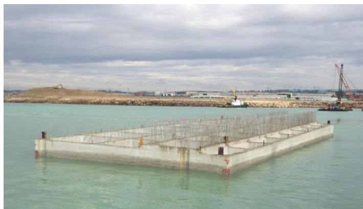
Figura 223. Dispositivo U-OWC in costruzione nella nuova darsena di Civitavecchia
