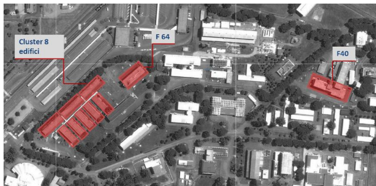
Figura 376. Rete di edifici dello Smart Village Casaccia
