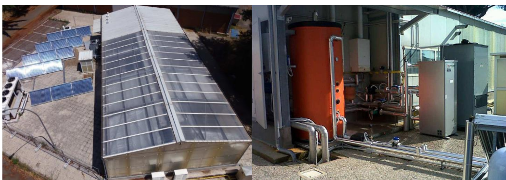
Figura 412. Impianto serra transgenica del C.R. ENEA Casaccia
