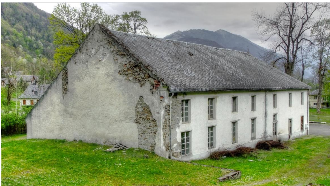
Fig. 8.26 - Edificio superstite della Manufacture Royale de Saffre et d'Azur de Saint-Mamet; immagine tratta da http://www.panoramio.com/photo/36420116 .
