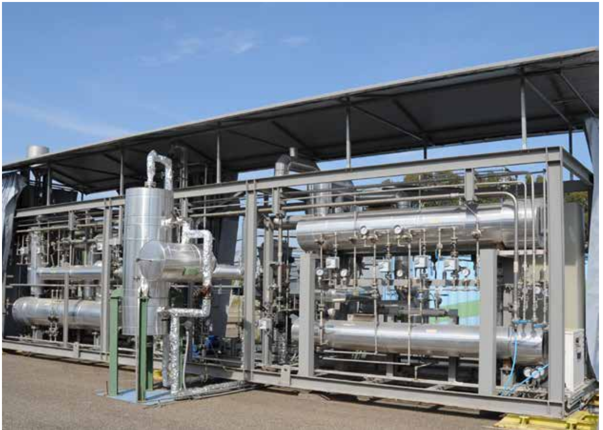
Figura 38: Impianto CFRP per la pirolisi a letto fisso
