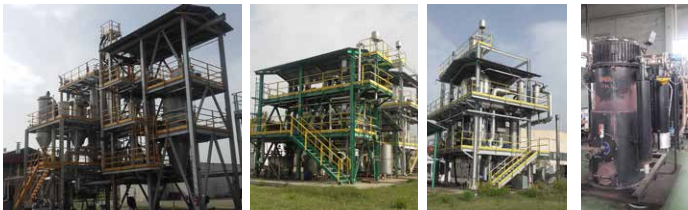
Figura 28: Impianti di gassificazione biomasse
