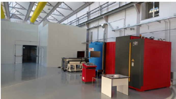
Cabina Radiografica e Tomografica da 450 KV e 150 KV
