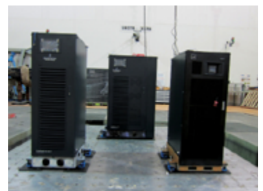
Test dinamico/funzionali su sistema sistemi UPS
