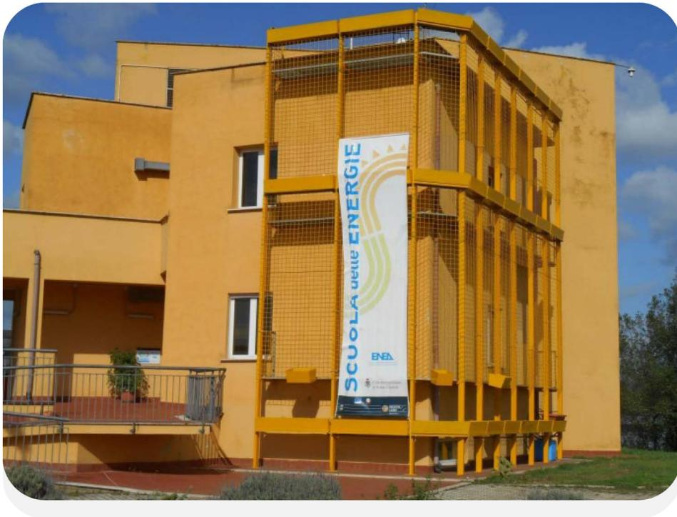
**Figura 5.14** - Struttura metallica applicata all'edificio che sorregge la parete verde (Report RdS/PAR2015/141<sup>42</sup>)
