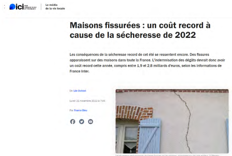
FIGURA 1-La siccità può causare gravi crepe nelle case, soprattutto su terreni argillosi.
