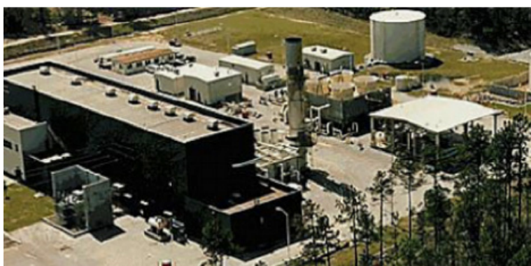
Impianto CAES entrato in funzione nel 1991, McIntosh, Alabama
