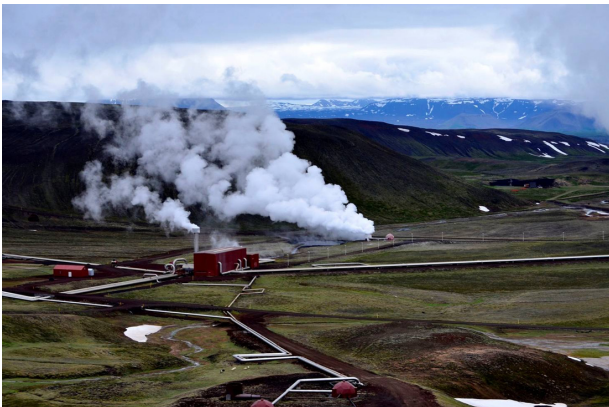
Impianto geotermico in Islanda
