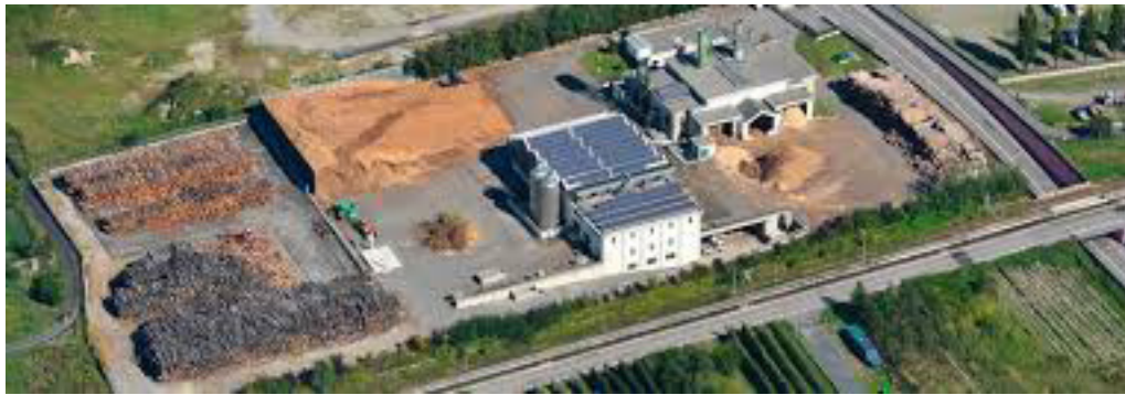
La centrale di Tirano (Fonte http://tcvvt.it/le-centrali/tirano )
