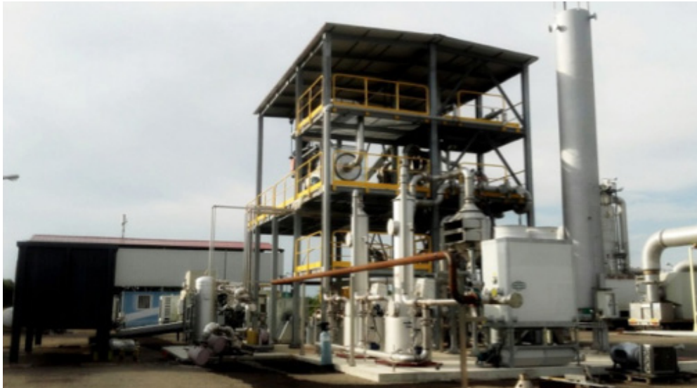
Gassificatore three stages – CR ENEA Trisaia
