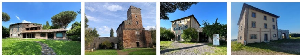
Figura 5-20. Edifici studiati nel Parco Archeologico dell'Appia Antica. Da sinistra a destra: Capo di Bove, Santa Maria Nova, Villa dei Quintili e Villa di Sette Bassi
