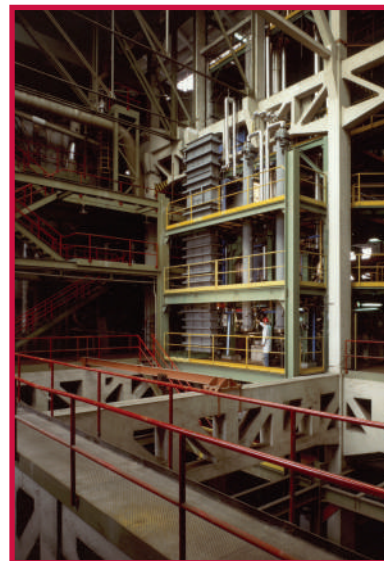
Impianto sperimentale SPES-2: vista laterale Nord zona sistemi sicurezza passivi (altezza totale impianto: 30 m)
