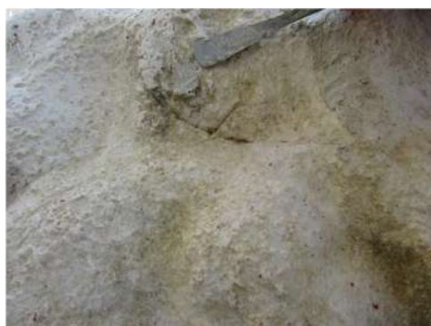
Fig. 7.4 - In alto: preparazione della malta con aggiunta di NopalCap; in basso: esecuzione della microstuccatura
