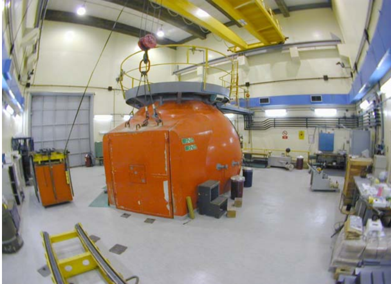
Figura 15 – Il Reattore TAPIRO. Sala reattore
