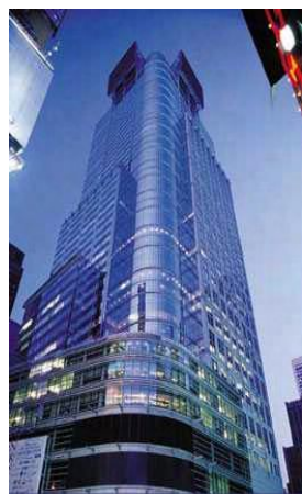
L'edificio di Times Square in cui sono installate due unità PureCell della UTC Power
