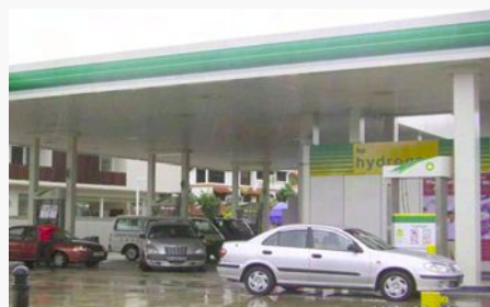
Stazione idrogeno BP (Singapore)
