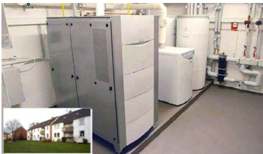
Esempio di installazione - Oldenburg, Germania
