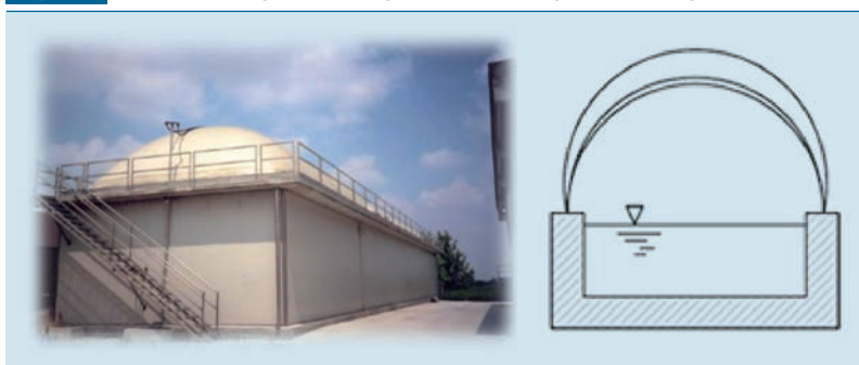
Fig. 2.2 Impianto semplificato con copertura a cupola
