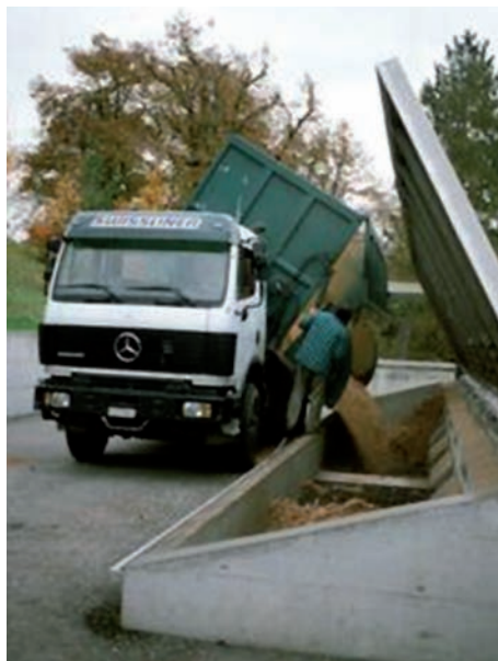
Figura 3.26 Silo per lo stoccaggio del cippato
