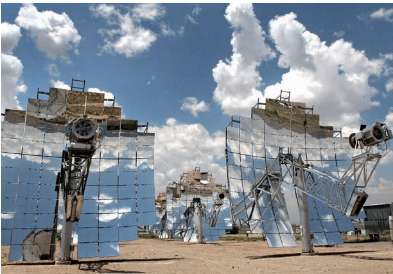
Figura 9.4 Collettori a dischi parabolici. La superficie riflettente insegue su due assi la radiazione solare e la concentra nel punto focale dove è posto il ricevitore
