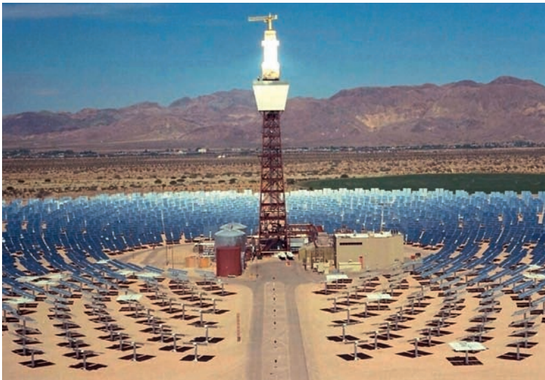
Figura 9.3 Collettore a torre centrale. Numerosi specchi concentrano la radiazione solare in uno stesso punto dove, sostenuto da una torre centrale, è collocato il ricevitore
