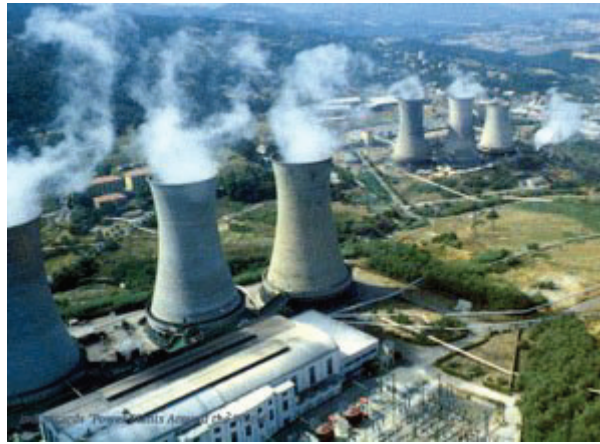
Foto 2.8 – Gli impianti geo-termoelettrici di Larderello (PI) alimentano anche le reti di teleriscaldamento dei centri urbani dell’area
