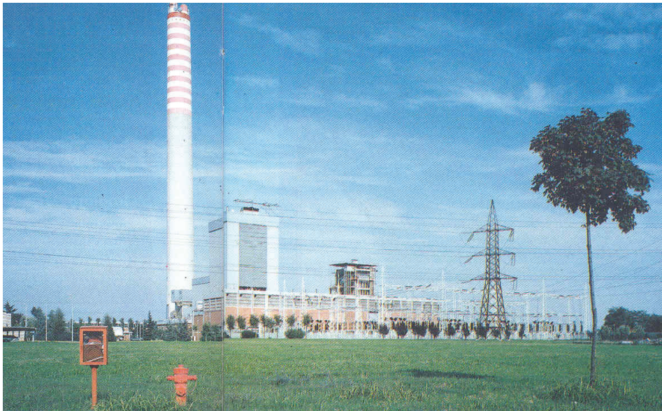
Foto 2.2 – Centrale termoelettrica che fornisce calore ad una rete di teleriscaldamento (centrale “non dedicata” di Cassano d’Adda)
