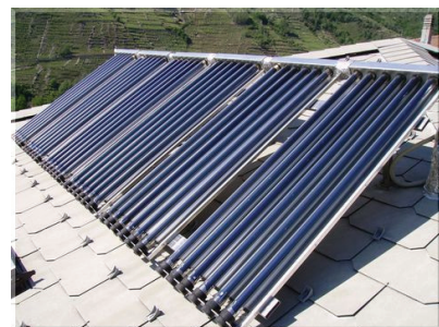
Foto 2.10 Impianto solare termico. Nel medio termine potrà essere integrato nelle reti di teleriscaldamento a bassa temperatura (tratta da: http://www.nbcsoftware.it/public/img_centro/solare.jpg )
