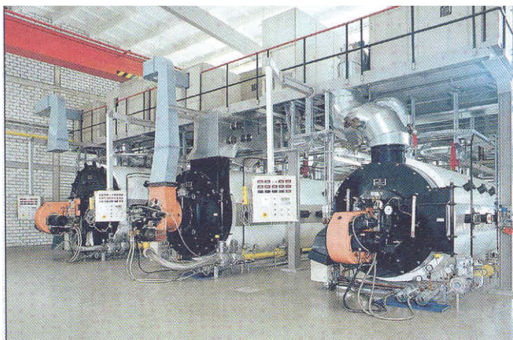
Foto 3.2 – Caldaie di grossa taglia installate presso un ospedale (circa 2 MW t cadauna)
