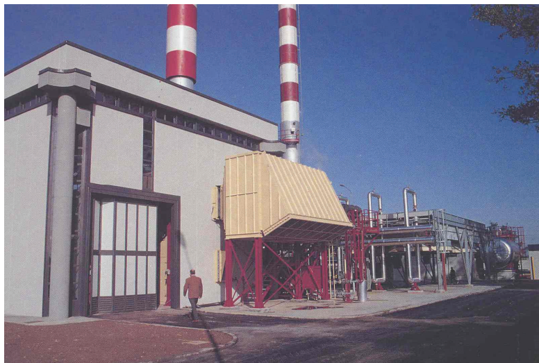
Foto 2.1 – Centrale di cogenerazione “dedicata” ad una rete di teleriscaldamento (Cremona Est)
