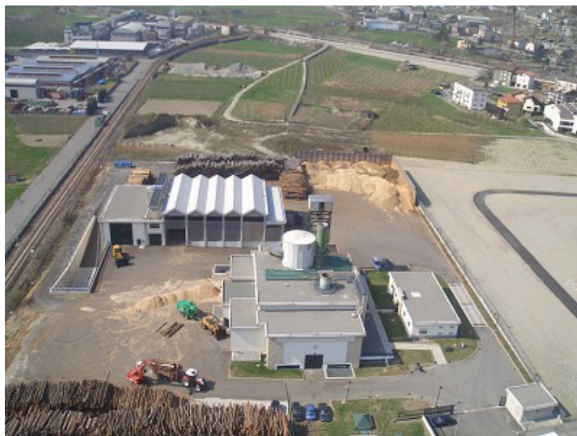
Foto 2.5 – Impianto di cogenerazione a biomassa al servizio di una rete di teleriscaldamento (centrale di Tirano – SO)
