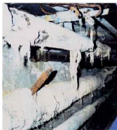
Figura 10.2 - Tubazioni coibentate con amianto in cui il coibente si presenta danneggiato (Credit: Arpa Torino)
