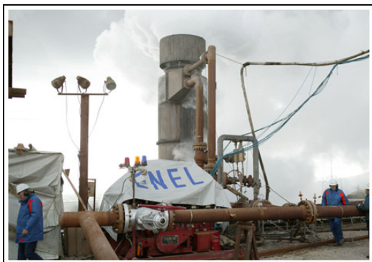
Figura 2.71 - Fase di perforazione di impianto
