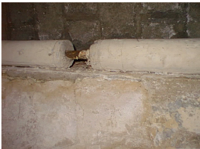
Figura 10.2 - Tubazioni coibentate con amianto in cui il coibente si presenta danneggiato (Credit: Arpa Torino)
