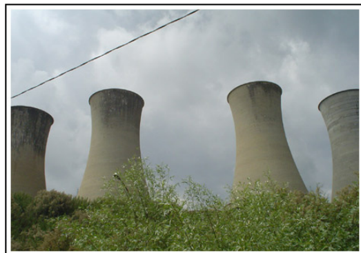
Figura 2.70 - Torri di raffreddamento dell'impianto di Larderello
