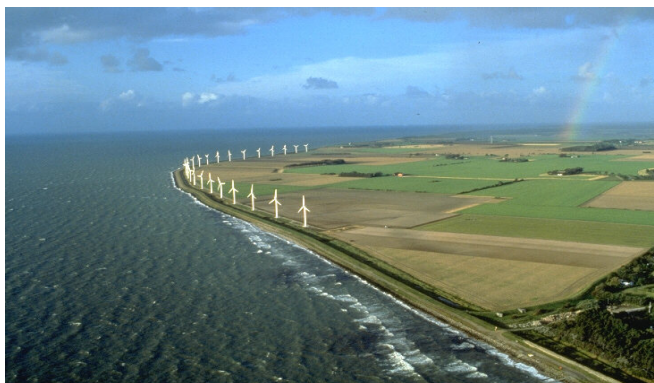
Figura 2.40 - Turbine tripala di una windfarm in Danimarca
