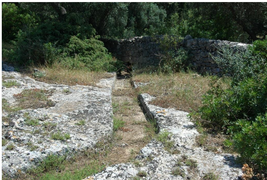
Figura 37 - Canale scavato nella roccia per il drenaggio e convogliamento dell'acqua piovana
