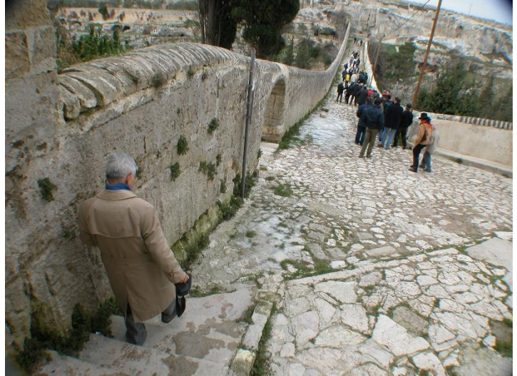
Figura 27 - Piano di calpestio del Ponte
