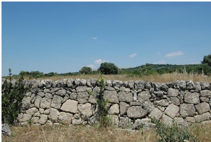
Figura 35 - Muretti a secco
