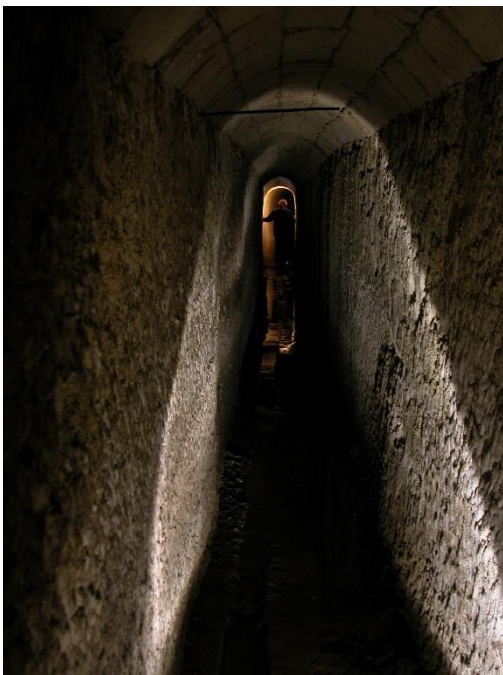
Figura 28 - Interno della galleria con volta a botte in blocchi di calcarenite
