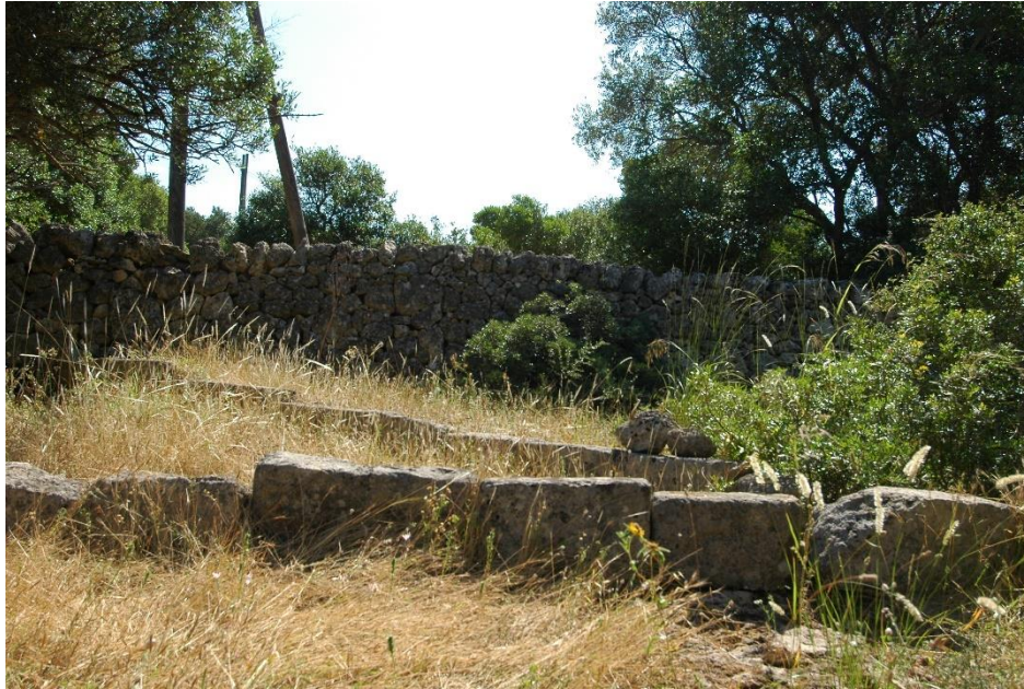
Figura 36 - Blocchi di calcarenite usati come ripartitori dei flussi dell'acqua
