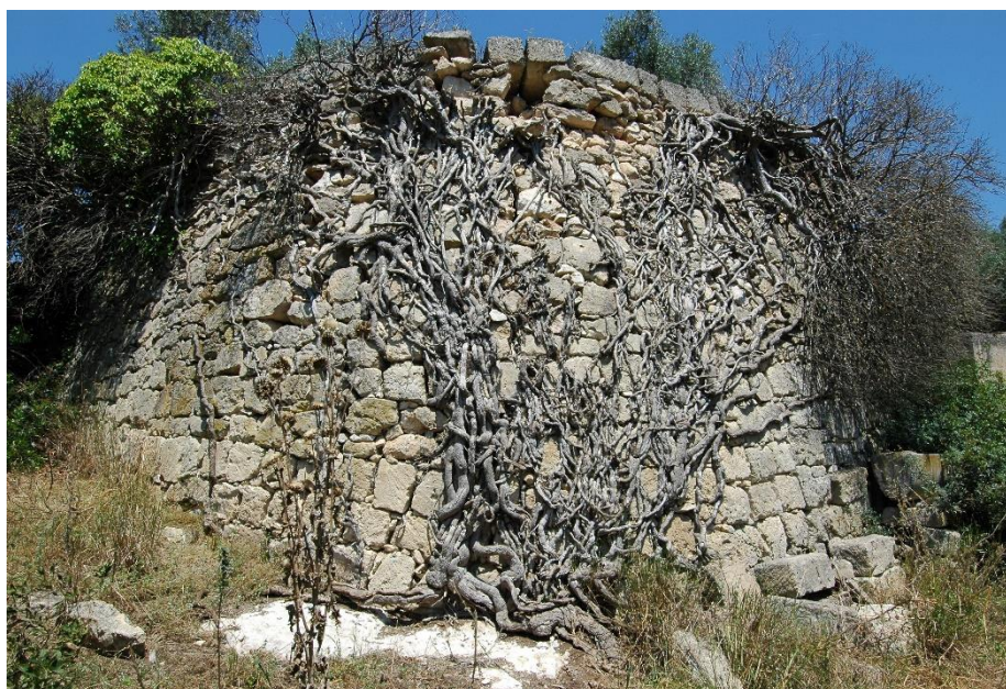
Figura 33 - Cisterna per la raccolta dell'acqua piovana
