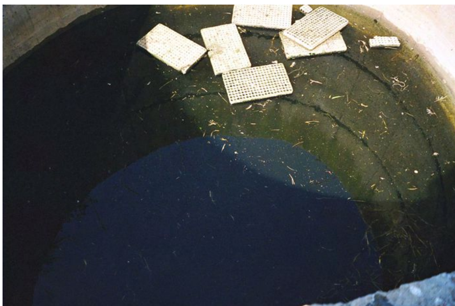
Figura 5.6 - Lo stato qualitativo di un pozzo a grande diametro
