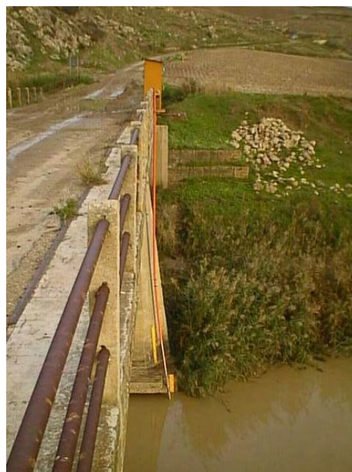
Figura 6.7 - Particolare della discesa del cavo
