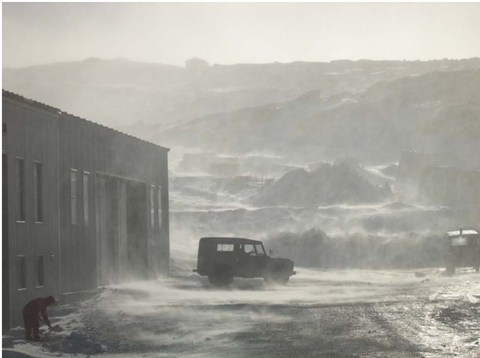
Figura 40 - La zona intermedia fra i due hangar della Base, sconvolta dal passaggio di un forte vento catabatico
