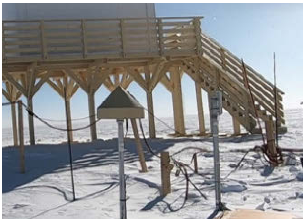
Prog. OSS-05: Stazione di misura DMC1 e relativa antenna presso lo shelter Sismo
