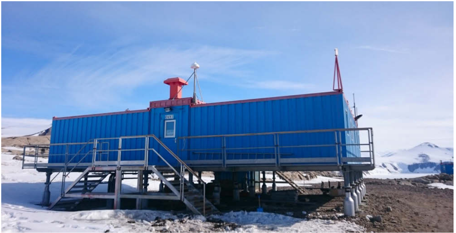
Prog. OSS-04: Installazione presso OASI dove è visibile l'antenna GNSS
