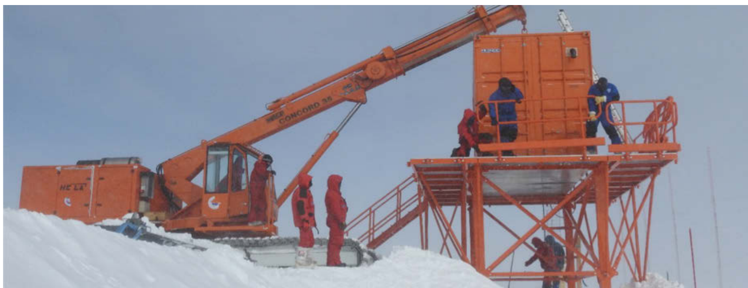
Prog. OSS-14: Posizionamento dello shelter DCN sopra la struttura Elphinstone
