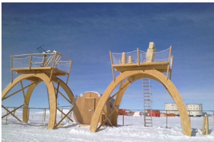
Prog. OSS-10: Collocazione del celiometro CL51 su una delle piattaforme dello shelter AstroConcordia
