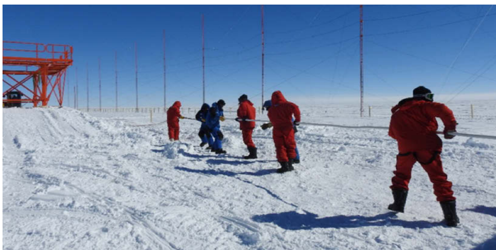
Prog. OSS-14: Posa dei cavi dati tra DCE e DCN
