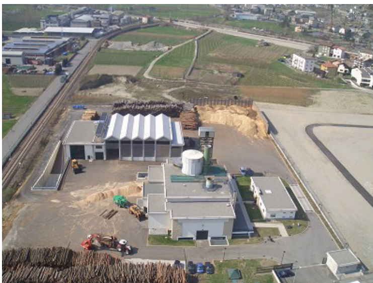
Figura 5.4 - Impianto di produzione di biogas da discarica (Tirano – Sondrio)
