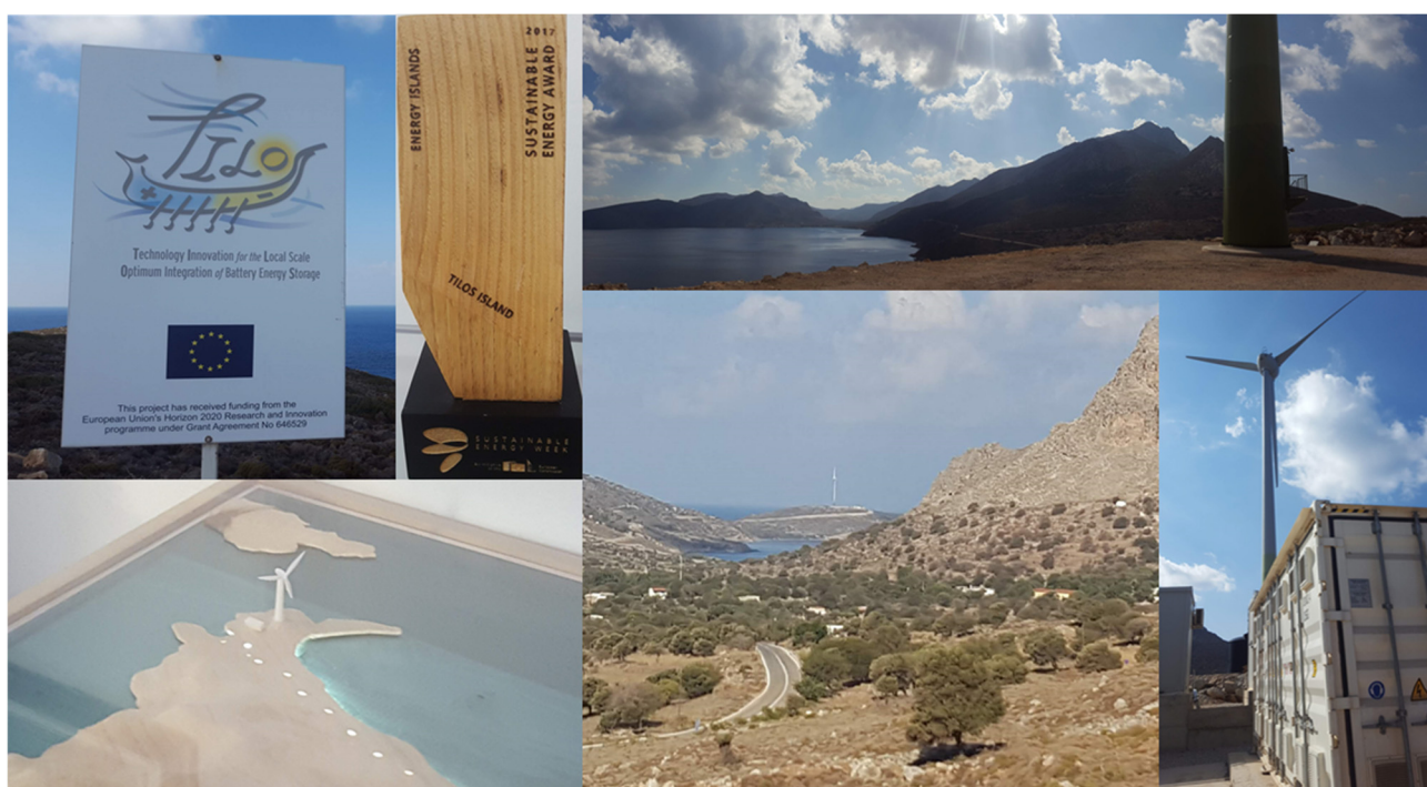
Figura 10.1 Aerogeneratore da 800 kW e sistema di storage installato nell'isola di Tilos in Grecia
