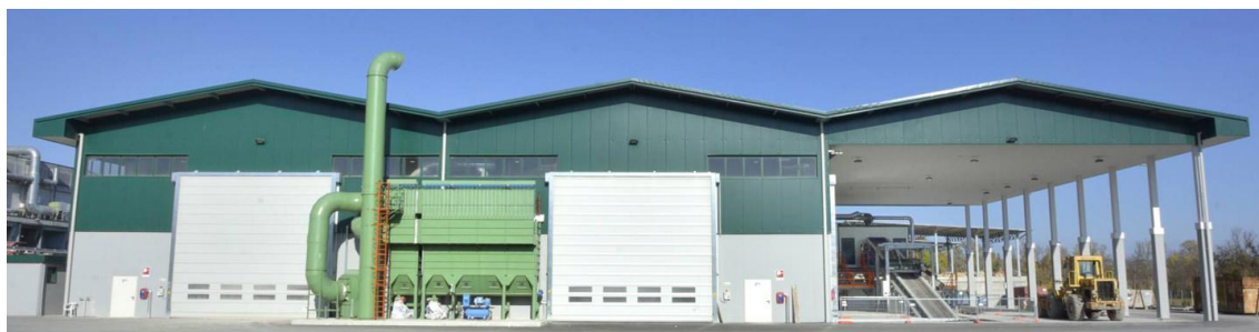
Figura 1: Capannoni installati per la movimentazione delle macerie all'interno dell'azienda Cosmari srl ( https://www.cosmarimc.it )
