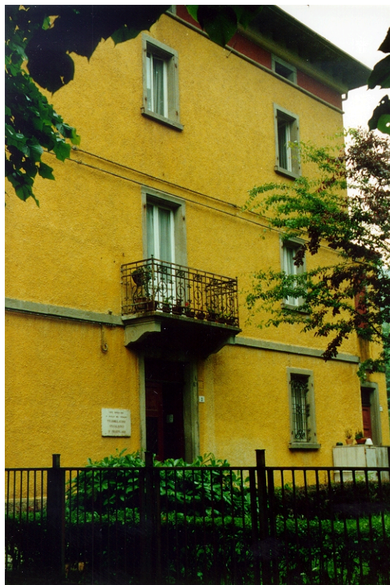
Foto 6.2 - L'edificio prima dell'intervento
