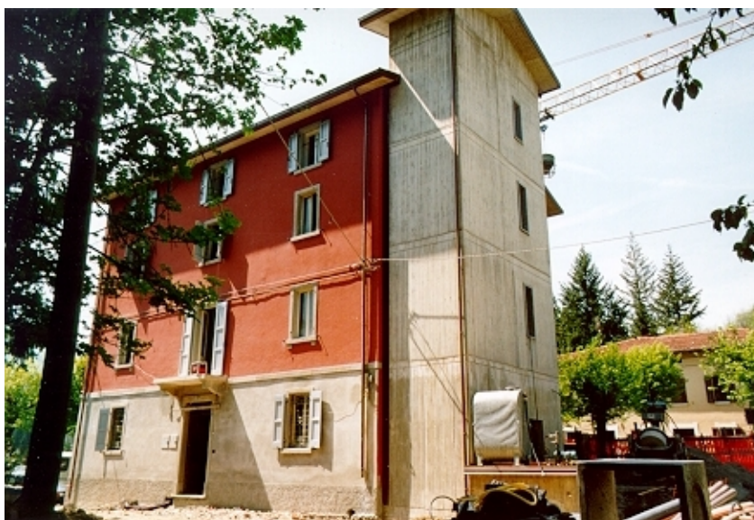
Foto 6.3 - L'edificio durante i lavori di miglioramento antisismico
