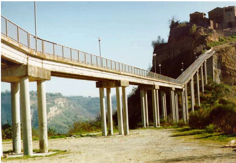
Foto 11.1 - Il viadotto pedonale di accesso a Civita di Bagnoregio
