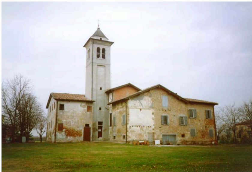
Foto 8.5 - Il Campanile dopo l'intervento
