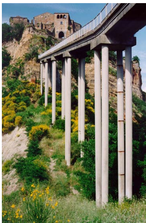
Foto 11.2 - Le pile P1, P2, P3, P4 e P5
