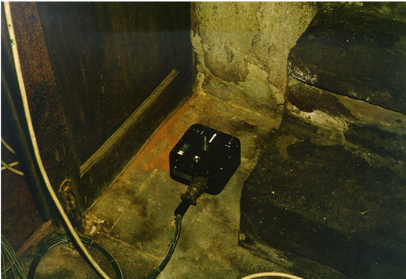
Foto 8.3 - Terna accelerometrica alla base
