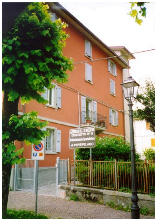
Foto 6.4 - L'edificio a lavori ultimati
