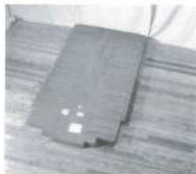
I primi tre strati di grafite del CP-1. Il primo reattore nucleare del mondo, noto come "pila" di Fermi, fu montato sotto lo stadio Stagg Field dell'Università di Chicago (novembre 1942) (per gentile concessione dell'Argonne National Laboratory)
