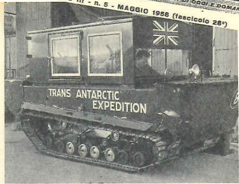
Il veicolo « Weasel » dopo essere stato trasformato da anfibio in trattore. A parte l'aggiunta dei cingoli che rimpiazzano le ruote, il veicolo mantiene ancora la forma di un natante.
