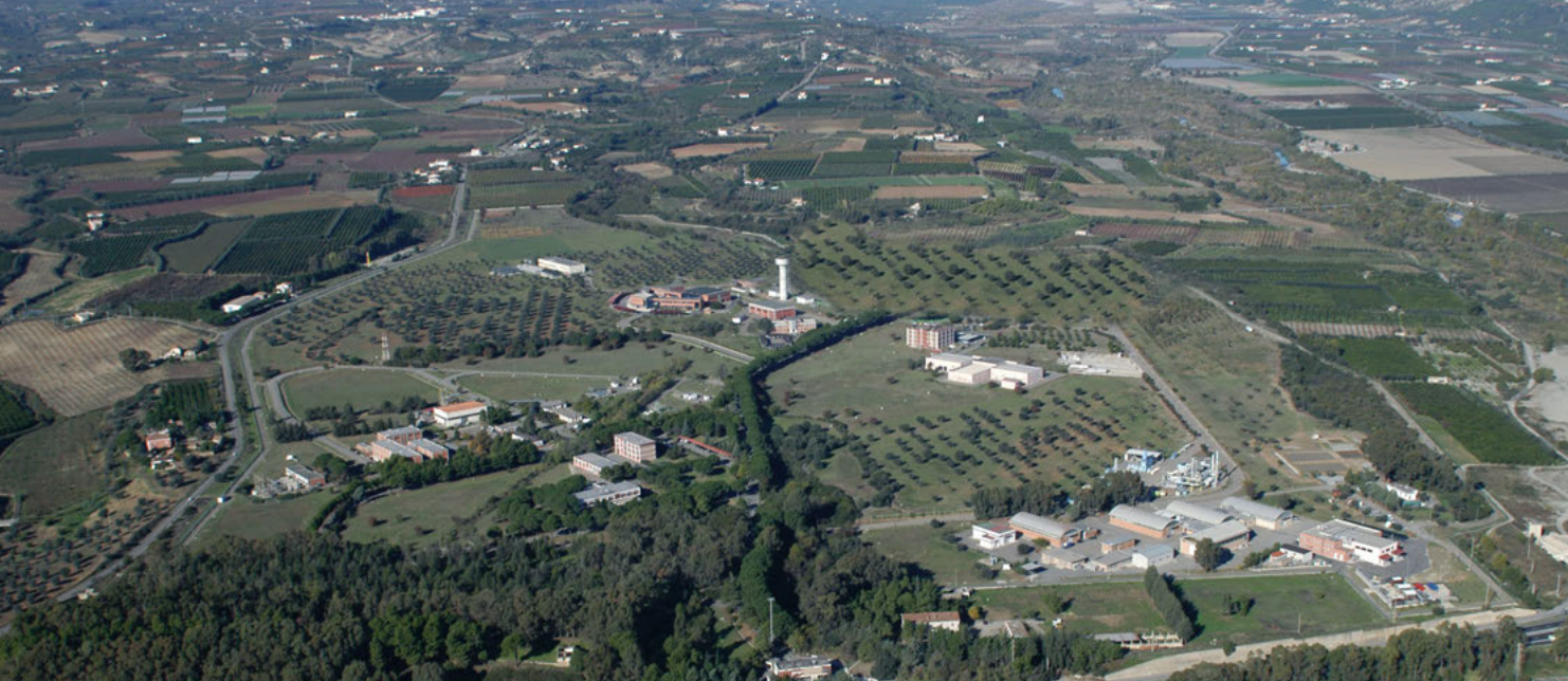
Figura 12: Veduta aerea dell'area dei terrazzi marini a ridosso della pianura costiera jonica, nella quale sorge il Centro di Ricerche ENEA della Trisaia.
