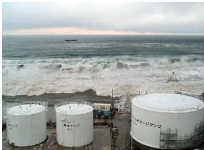
Fig. 1 L'onda (alta circa 14 m) investe la centrale nucleare di Fukushima Daiichi, scavalcando le barriere di protezione (alte circa 6 m) ed invade i locali della centrale
