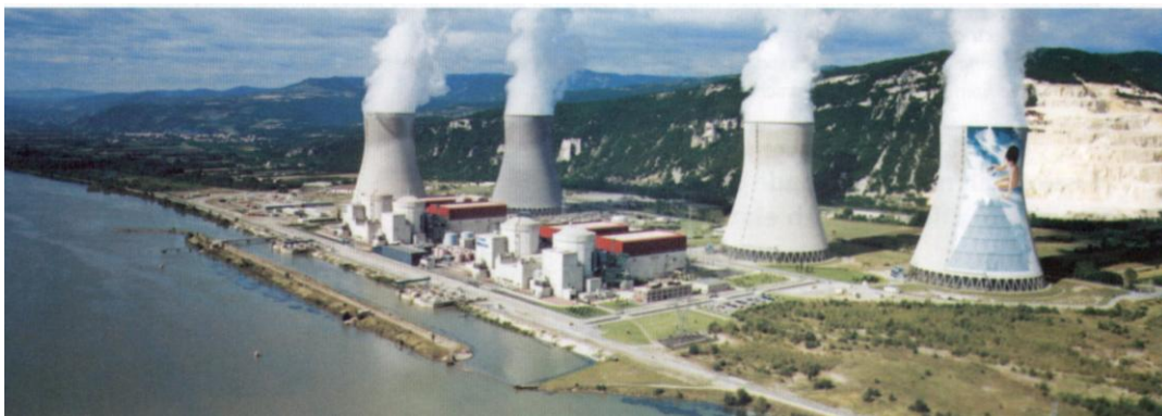
Fig. 4 La centrale di Cruas, Francia, primo esempio di applicazione dell'isolamento sismico in campo nucleare (reattori entrati in esercizio nel 1983-84; isolatori progettati, realizzati ed installati negli anni '70)
