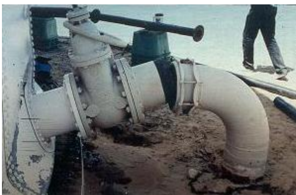
Fig. 3 Terremoto di Landers (CA), 28/06/1992, M_w=7.3 : danni alle tubazioni rigide
