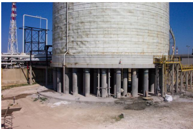
Fig. 3 Ripresa fotografica nel corso dei lavori
