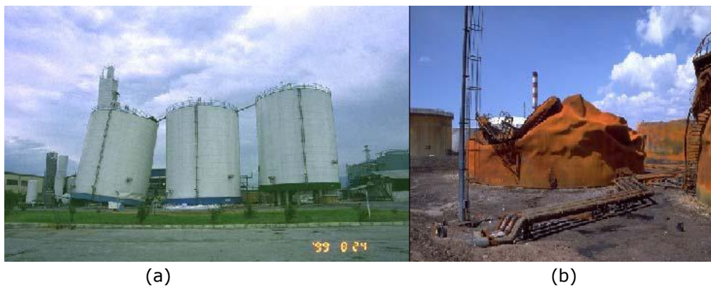
Fig. 3 (a) Elephant-foot buckling , (b) cedimento delle strutture di supporto e collasso
