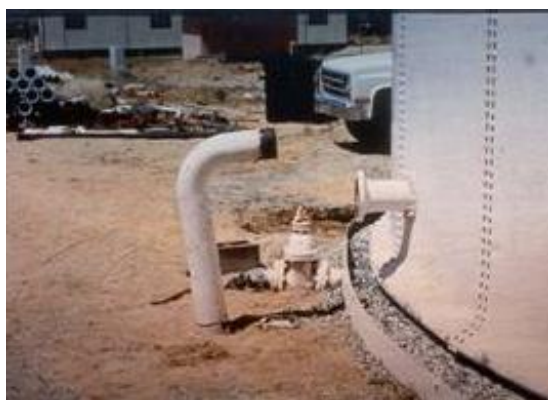
Fig. 3 Terremoto di Landers (CA), 28/06/1992, M_w=7.3 : danni alle tubazioni rigide
