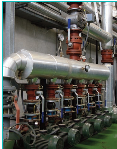
Serie di 6 pompe ad acqua per circuito idraulico caldaie
