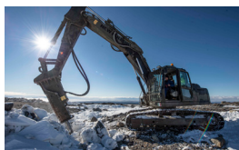
Baia Terra Nova Lavori sulla pista a Boulder Clay Autore: P. Sammaciccio ©PNRA
