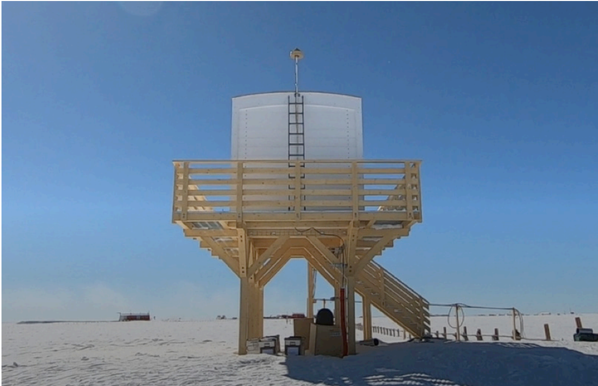
Prog. OSS-05: Installazione antenna sul tetto del nuovo shelter Sismo (A.Salvati ©PNRA)NRA)
