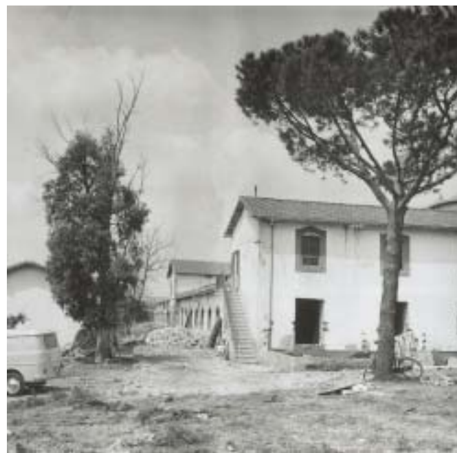
La vaccheria della fattoria "La Casaccia" all'epoca dei lavori di trasformazione (23 aprile 1959). La vaccheria è oggi sede della biblioteca del Centro
