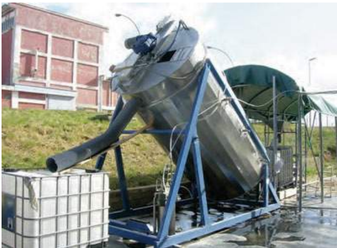
Processi biologici: digestore anaerobico mobile
